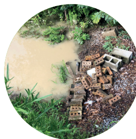
Absence d'écoulement dans la canalisation
